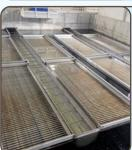
Las partículas en suspensión floculadas y las sustancias químicas se sedimentan en el tanque de sedimentación. Los asentadores de placas inclinadas aceleran el proceso de sedimentación. El lodo que se forma es bombeado hacia los procesos de manipulación de sólidos
