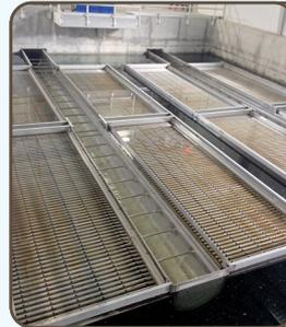
Las partículas en suspensión floculadas y las sustancias químicas se sedimentan en la balsa de sedimentación. Sedimentadores de placas inclinadas aceleran el proceso de sedimentación; los lodos que se forman se bombean hacia los procesos de manipulación de sólidos.
