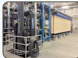
Las membranas tienen 6,350 fibras en cada módulo y 124 módulos en cada rejilla. Cada fibra tiene poros con un tamaño nominal de 0.1 micras cada uno.
